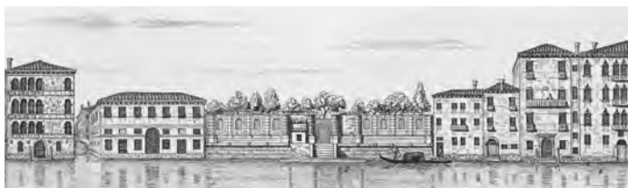
4 »Il palazzo non finito« – das abgebrochene Bauvorhaben der Veniers. Gravur von 1831.
