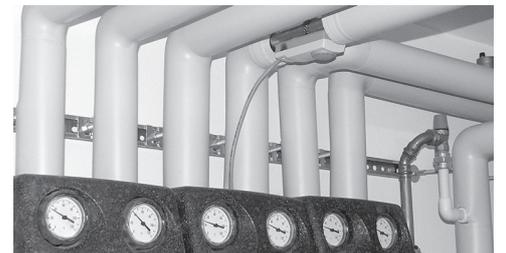
**Bild 1.7:** Gedämmte Rohrleitungen.
