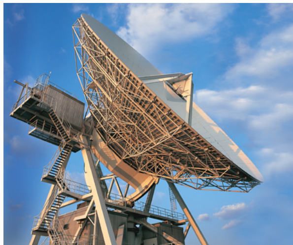
Bild 1.2.7: Große (30 m) S-Band-Antenne der DLR-Bodenstation Weilheim (Bild: DLR).
