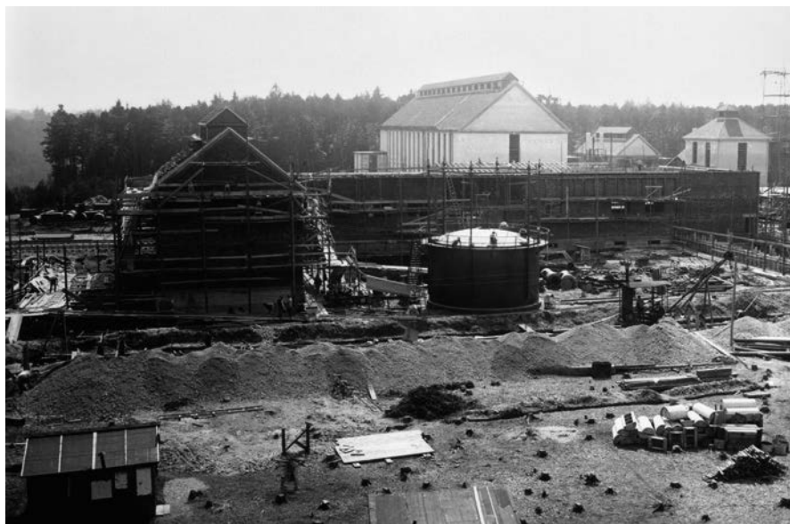
Acetylenanlage und Acetylen-Gasometer im Bau 1916
