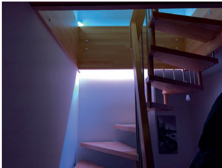
Bild 2.7 LED-Strips an der Treppe variieren in der Helligkeit je nach Tageszeit (© Chris Bertko).
