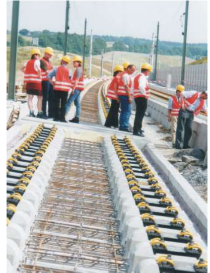
Bild 2.5 Überhöhung im Kreisbogen (im Bau)
