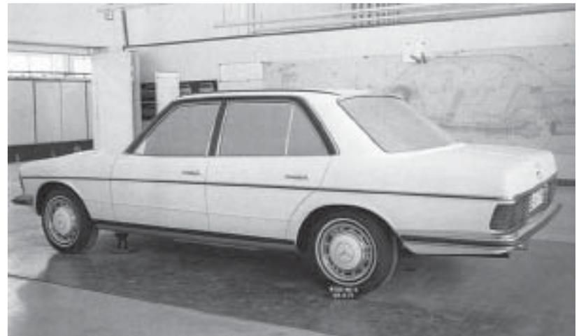
An diesem 1:1-Modell vom August 1971 fallen die schlanke Linie, das großzügige Glashaus und die markanten Dachleisten nach dem Barényi-Patent ins Auge.
