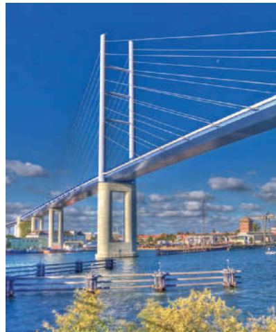
Rügenbrücke über den Strelasund
