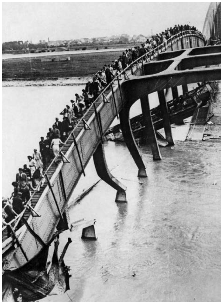
2 Provisorischer Personensteg auf den Trümmern der gesprengten Floridsdorfer Brücke 1945
