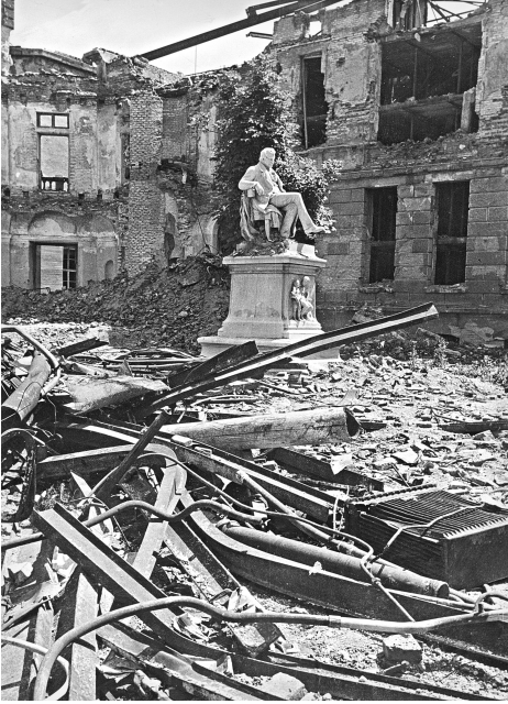
Der zerstörte Lichthof der Universität
