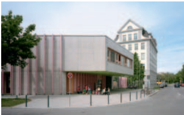
Der leicht abgeknickte Haupteingang | The slightly angled main entrance
