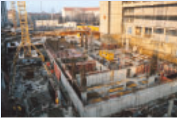
Baustelle für den Neubau des Fernmeldeamtes Dresden.
