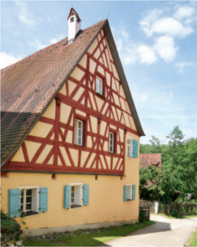
Gelungenes Beispiel für wieder hergestelltes Fassadenbild und angepasstes Farbkonzept: Bauernhaus im Nürnberger Land
