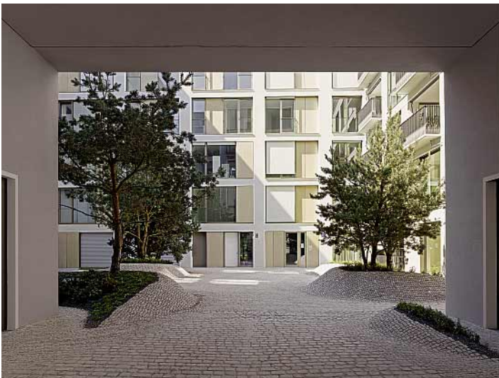
1–5 Wohnhäuser an der Hotterstraße
