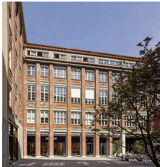
1–4 Ansicht des alten Druckereigebäudes
