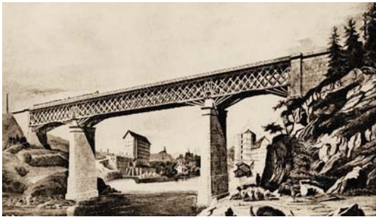
Von 1853 stammt die hölzerne Eisenbahnbrücke, die bei Kempten die Iller überquert
