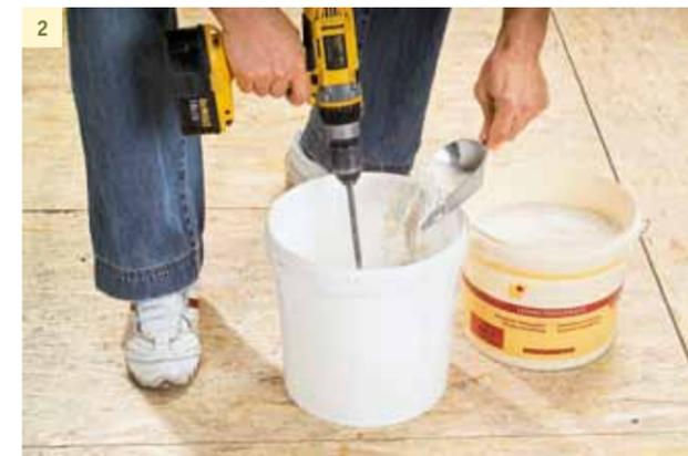
1 Farbtöne mischen: Pigmentpulver und Putztrockenpulver zusammen in einen Eimer geben und so lange vermischen, bis ein homogener Farbton entsteht.
