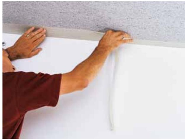
Abkleben: Stellen Sie zunächst die Raumdecke fertig. Kleben Sie nach dem Trocknen die Deckenfläche ab. Ebenso kleben Sie die angrenzenden Wandflächen ab.
