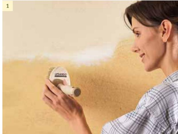
Um einen homogenen wolkigen Effekt beispielsweise mit zwei Farbtönen zu erzeugen, ist es erforderlich, die Lasurbürste in zwei Farbeimer abwechselnd einzutauchen und je nach Farbwunsch Farbe zu entnehmen. Legen Sie sich kein festes Muster fest. Arbeiten Sie gleichmäßig und zügig über die Fläche und verharren sie nicht krampfhaft an einer Stelle, um keine Ansätze zu erzeugen.
