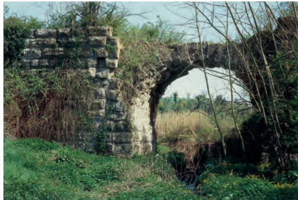
Abb. 3 Unter den Kunstbauten römischen Straßenbaus beeindruckten die gewaltigen Rampen, die wichtigere Straßen aus dem Talgrund geradenwegs auf die Höhe hinauf führten, wie die Rampe der Via Appia bei Ariccia, oder diese – ganz von Vegetation bedeckte – rund 250 m lange Rampe der Via Flaminia im Treja-Tal, deren volkstümliche Bezeichnung Muro del Peccato die Ratlosigkeit angesichts eines solch kolossalen Bauwerks erkennen läßt.
