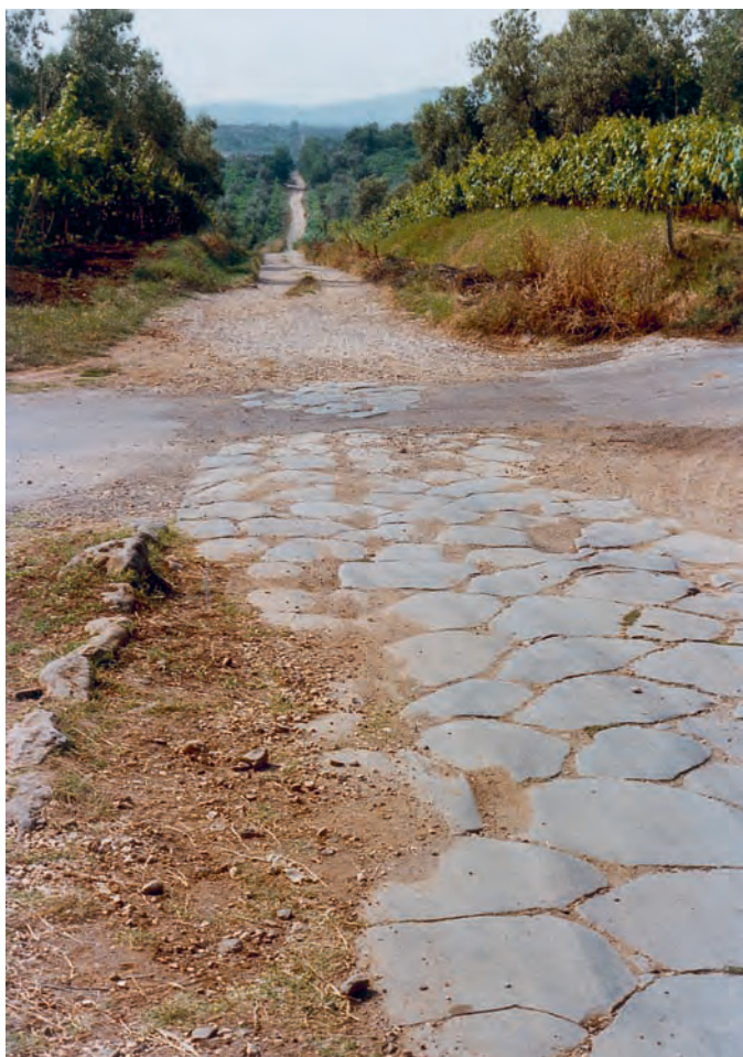
Abb. 10 Den geraden römischen Straßentrassen folgte man weiterhin gern, aber nicht mehr über größere Distanzen. Wo eine Brücke eingestürzt, eine Böschungsmauer geborsten, ein Sumpf entstanden war, beseitigte man diese Hindernisse oft nicht mehr, sondern umging sie. So bildeten sich die im Ganzen auffallend geraden, aber leicht ausschweifenden, wie mit zittriger Hand gezogenen Strecken, die doch immer wieder in die römische Gerade zurückfielen, wie hier an der Via Appia in den Weinbergen bei Velletri.
