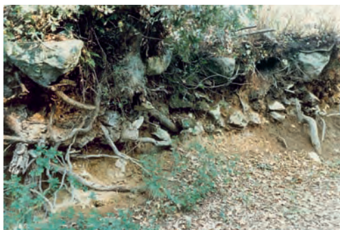
Abb. 15 Das Pflaster der Via Flaminia längs erodiert in einer – jahreszeitlich wasserführenden – Geländerinne, durch die nun ein Pfad annähernd der alten Trasse folgt. Dichtes Wurzelwerk hält vier Pflastersteine gerade noch in ihrer ursprünglichen Lage (rechts scheint ein weiterer vor kurzem abgestürzt). Unter der Straßendecke erkennt man zunächst eine dünne Schicht von Sand oder feinem Kies, darunter eine Schüttung von grobem Schotter. Via Flaminia beim Abstieg ins Tal der Treja.
