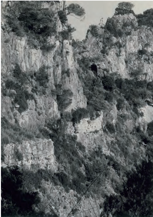
Abb. 8 Eine derart kühne Straßenführung, wie sie die Via Flacca an der Felsküste zwischen Sperlonga und Gaeta aufweist (zahlreiche Abarbeitungen, hohe Substruktionsmauern, sogar ein Tunneldurchstich im Hintergrund links), war, wenn regelmäßige Inspektion und Instandhaltung aufhörten, nicht mehr zu halten. Und da man, anders als in ebenem Gelände, zwischen Fels und Meer ein entstandenes Hindernis nicht umgehen konnte, mußte man auf die Via Appia weiter im Innern ausweichen. Via Flacca, Punta di Trapani bei Sperlonga.
