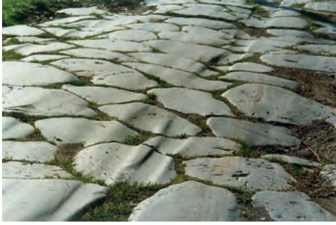
Abb. 19 Römisches Pflaster kann Jahrhunderte fast unbeschadet überdauern, ja die in die Pflasterdecke eingeschliffenen Radspuren erhöhen noch den Eindruck der Geschlossenheit. Zwar zeigt die Pflasterung – etwa auf stadtnahen Strecken der Via Flaminia – stellenweise starke Abnutzungsspuren. Aber es ist nicht Abnutzung, was in nachantiker Zeit zum Aufgeben von Pflasterstrecken führt, sondern zerstörte Brücken, Auswaschung durch querende Wasserläufe, Umorientierung des Verkehrs auf andere Ziele – und die verbreitete Abneigung gegen solch massives Pflaster. Via Praenestina westlich S. Maria di Cavamonte.
