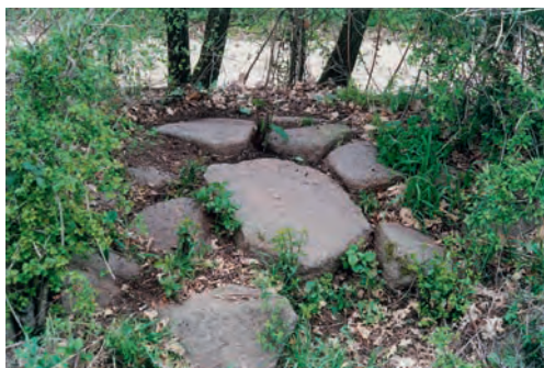
Abb. 18 Römische Pflasterung kann aber von selbst aus den Fugen geraten, wenn es, auf schmalen gewölbtem Damm zwischen begleitendem Fahrweg und beackertem Feld, beide tiefer liegend, über die Flanken des Damms allmählich hinabgleitet, und sich so die Fugen öffnen. Wo sich die Fugen aber so weit öffnen, werden Baum und Gebüsch die Pflasterung umso leichter sprengen und die zur Grenze gewordene antike Straße zu noch dichterem Heckemachen. Via Amerina, nördl. Karte Punkt 56.
