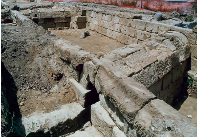
Abb. 6 Römischer Straßenbau leistete sich aufwendige Kunstbauten auch in weniger schwierigem Gelände. Um der Via Ostiense an leichtem Hang einen gleichmäßigen Anstieg zu verschaffen, wurde ein hoher Straßendamm errichtet (die parallelen Einfassungsmauern hier ausgeräumt), der, um nicht als Sperre zu wirken, mit gewölbten Durchlässen für Wasser, Mensch und Vieh versehen war. Ohne Wartung konnten sich hier Hohlräume, Breschen, versumpfte Stellen bilden. Via Ostiensis bei Acilia (1997, zerstört).
