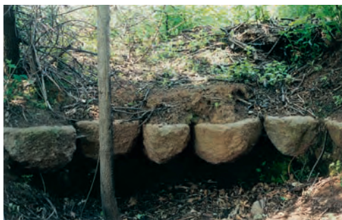
Abb. 17 Römische Pflasterung ist so kompakt gefügt («als seien die Steine nicht ineinander verfugt, sondern miteinander verwachsen», sagt Prokop, Gotenkrieg I 14, noch im 6. Jahrhundert vom Pflaster der Via Appia), daß die Steine, selbst wenn die Bettung darunter stellenweise verschwunden ist, sich noch gegenseitig in der Schwebelage halten. Bei moderner Wiederausführung antiker Pflasterung gelingt solch dichte Fugung nicht. Via Amerina, nördl. Karte Punkt 56.
