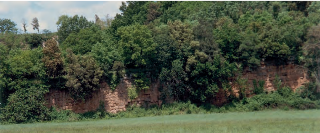
Abb. 3 Unter den Kunstbauten römischen Straßenbaus beeindruckten die gewaltigen Rampen, die wichtigere Straßen aus dem Talgrund geradenwegs auf die Höhe hinauf führten, wie die Rampe der Via Appia bei Ariccia, oder diese – ganz von Vegetation bedeckte – rund 250 m lange Rampe der Via Flaminia im Treja-Tal, deren volkstümliche Bezeichnung Muro del Peccato die Ratlosigkeit angesichts eines solch kolossalen Bauwerks erkennen läßt.
