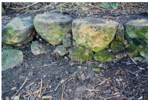
Abb. 16 Querschnitt durch römisches Pflaster. Die großen, unten konisch zugerichteten Basaltpflastersteine werden – zweitoberste Schicht des Straßenkörpers – in eine Schicht Kies gebettet und gegebenenfalls mit kleineren Steinen verkeilt. Querschnitte römischen Pflasters treten in der Wand querender Bachbetten zutage, oder in der Wand moderner Straßeneinschnitte wie hier das Pflaster der Via Amerina bei Campagnano Romano, Karte Punkt 4.
