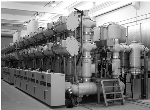
Bild 2 145 kV gasisolierte Schaltanlage (gekapselte Anlage); (Quelle: Siemens AG).
