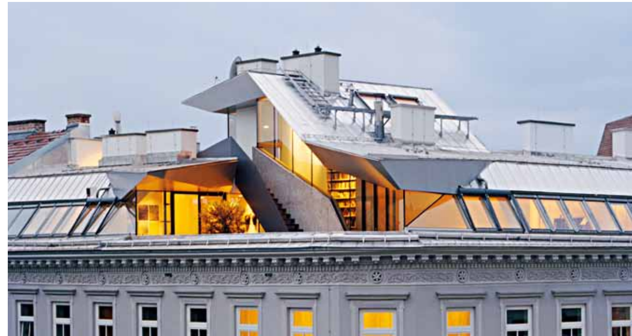
Was für ein Auftritt! Die großzügig verglaste Dachwohnung ist das moderne Pendant zu Nest, Baumhaus oder Felsenhorst. Sie erlaubt kaum Einblicke, dafür umso mehr Ausblicke.
