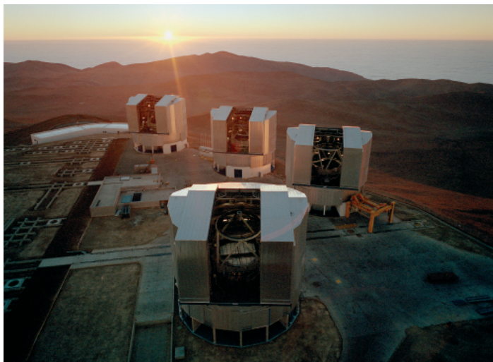
Abb. 2: Das Very Large Telescope (VLT) der Europäischen Südsternwarte (ESO) auf dem 2635 Meter hohen Cerro Paranal in der Atacamawüste im Norden Chiles ist eines der größten und leistungsfähigsten Spiegelteleskope der Welt. Die vier gleichartigen Teleskope, jedes mit einem Spiegeldurchmesser von 8,2 Metern, können sowohl einzeln benutzt werden als auch über entsprechende Strahlführungen zu einem einzigen Teleskop zusammenschaltet werden.
