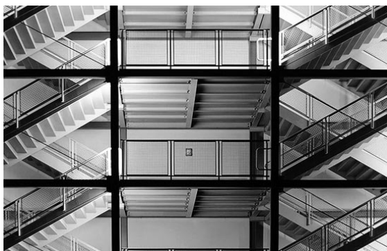
Das Treppenhaus der Parkgarage, unterteilt entsprechend der Drittelregel.
