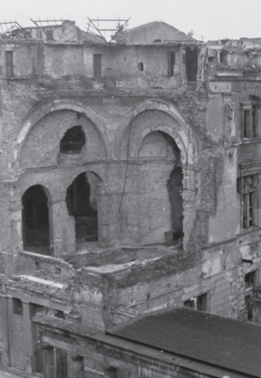
Blick auf Ost- und Südfassade mit der zerstörten Südkuppel, 1946
