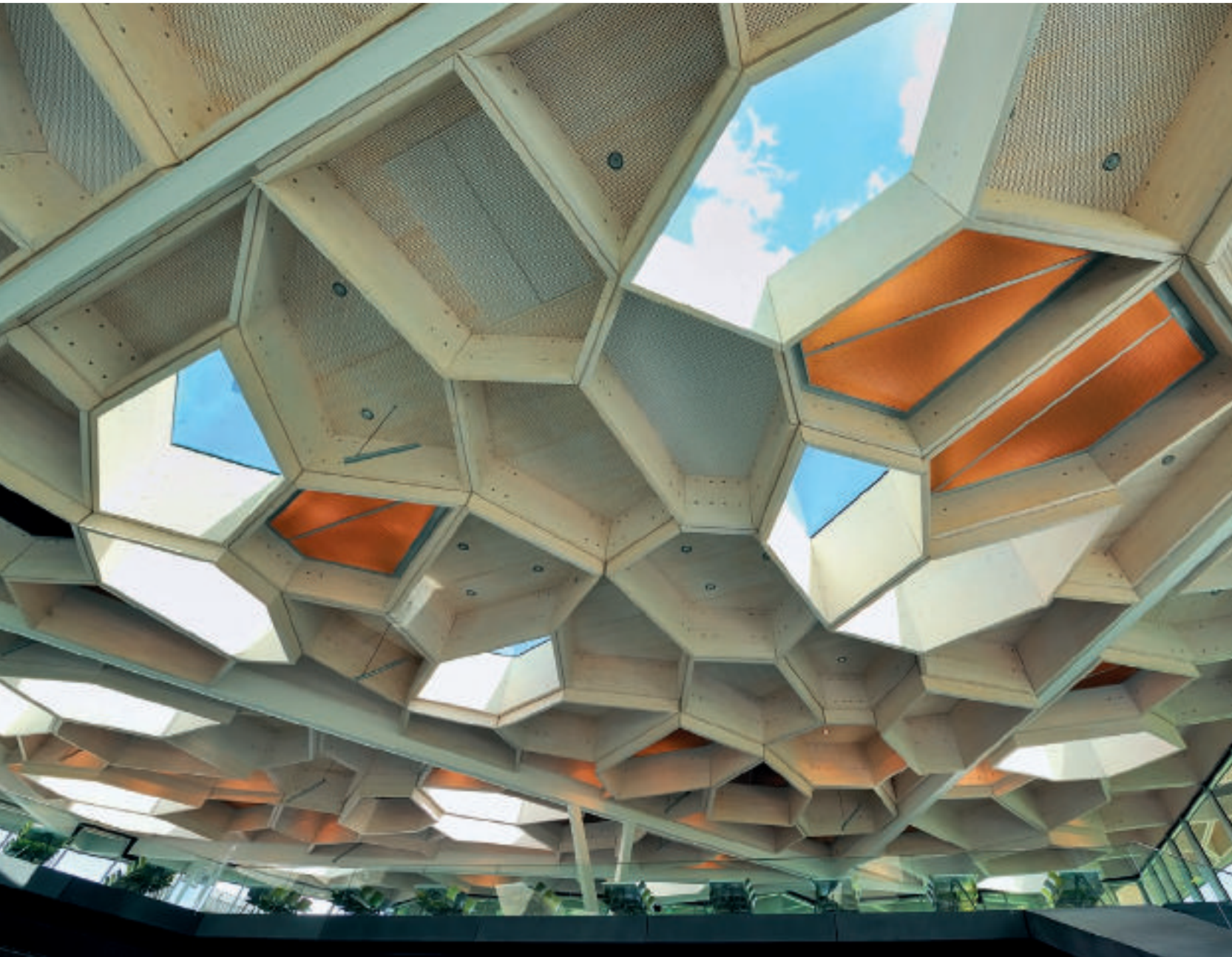
Die Tiefe der Dachwaben variiert von 90 bis 150 Zentimetern, so dass die Untersicht plastisch ausgeformt wirkt. The depth of the roof cells varies between 90 and 150 centimetres, making the lower surface seem to be moulded sculpturally.
