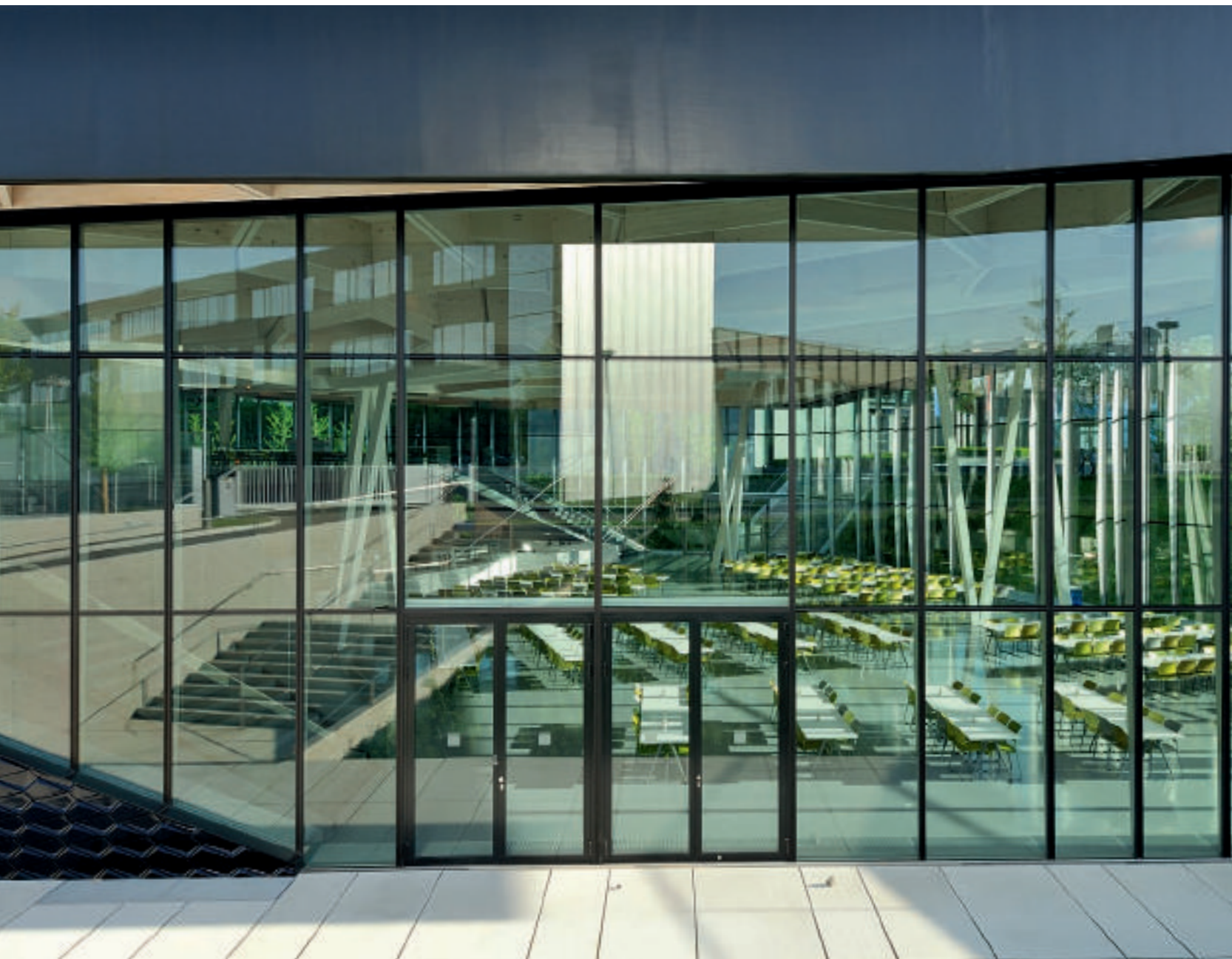
Schräg stehende Baumstützen im lichten Einraum | Tilted tree-like supports in the bright, soaring interior
