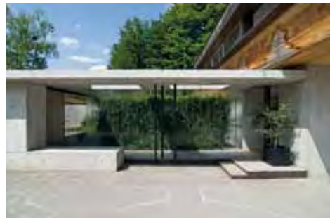
Links Ein »fliegendes Dach«, ausgeführt als Sichtbeton-Scheibe, verbindet den Hauseingang (rechts) mit Nebenhaus und Carport.
