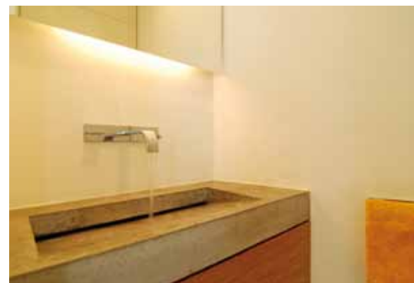
Oben und ganz oben Die Sanitärausstattung wurde einheitlich in Sichtbeton ausgeführt – oben die Badewanne im Kinderbad, unten das Waschbecken in der Toilette; indirekte Beleuchtungen sorgen für Flair.
