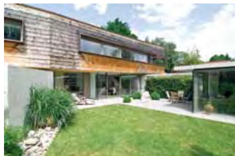
Rechte Seite oben links Der Wohnraum mit der davor liegenden überdachten Terrasse und dem Garten bilden ein Kontinuum zusammenhängender Außen- und Innenräume. Oben Mitte und unten Die Häuser sind nicht tief, aber breit: die Küche steht bereits vor der Rückwand des Hauses; der Eingangsbereich wird durch die skulptural an einer Sichtbetonscheibe geführten Treppe abgeteilt. Oben rechts Der relativ kleine Wohnbereich gibt sich als Leseecke mit Kamin.
