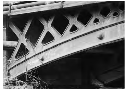
Bild 3. Gusseiserne Straßenbrücke über den Erlengraben bei Ettlingen aus dem Jahr 1852; Detailansicht [62]
