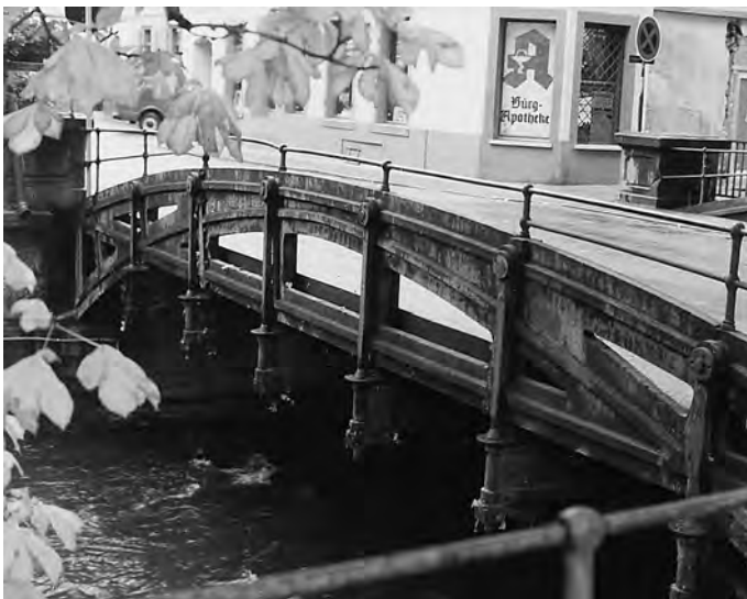
Bild 4. Gusseiserne Brücke über den Neumagen in Staufen aus dem Jahr 1845, ursprünglich als Eisenbahnbrücke in Hecklingen im Einsatz [62]
