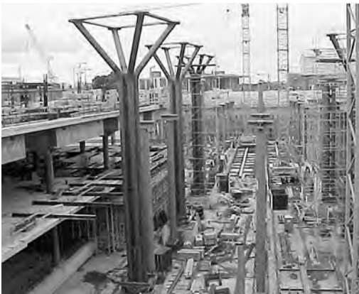
Bild 7. Gabelstützen im Lehrter Bahnhof [63]
