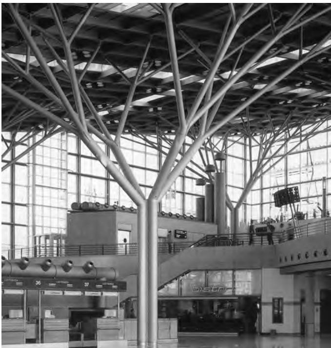
Bild 5. Flughafengebäude in Stuttgart. Die Knoten der Baumstützen sind aus Stahlguss hergestellt und mit Rohren verschweißt
