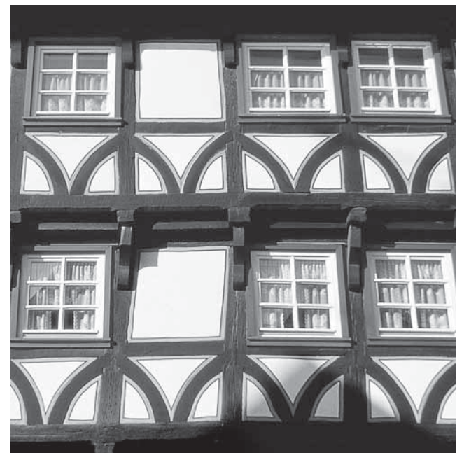
Typisches Merkmal end-mittelalterlicher Fachwerkstrukturen sind Einzelverstreben aller Ständer, Beispiel mit Radstreben in Alsfeld.
