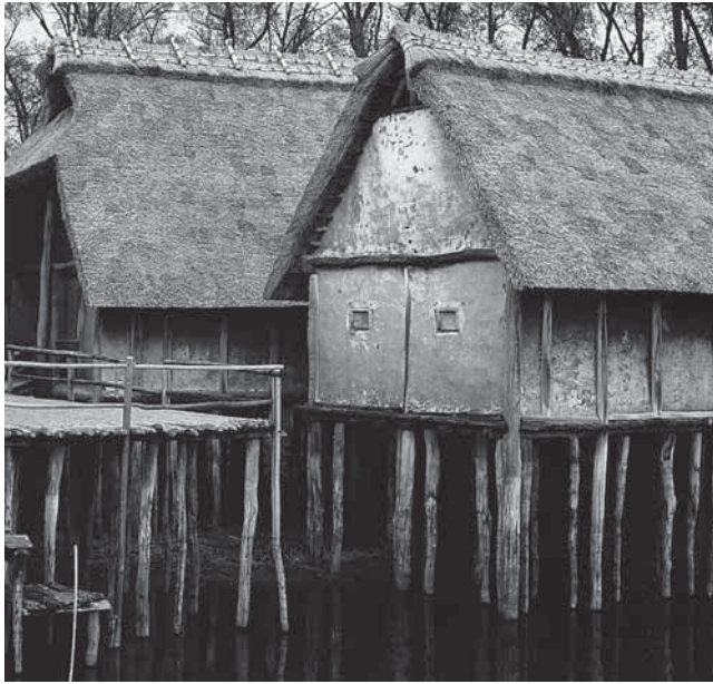
Unteruhldingen: Pfosten- und Pfahlbauten mit Schwellriegeln und von der tragenden Konstruktion unabhängigen Flechtwerk-wänden, mit Lehm vestrichen
