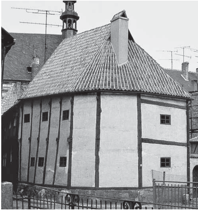
Der „Ständerbau“ in Quedlinburg, Wordgasse 3, 1. Hälfte 15. Jahrhundert, ist ein typischer Geschossbau mit 2 Geschossen und Hochrähmverzimmerung.
