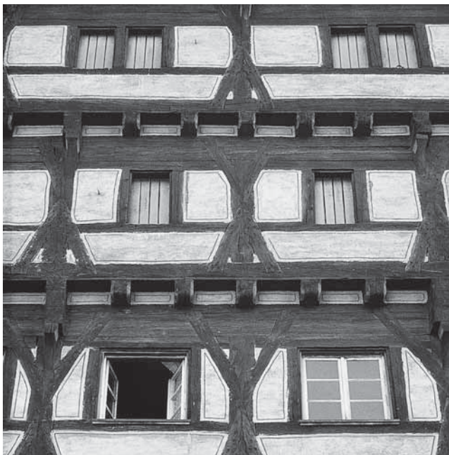
Typische Stockwerksrahmenverzimmerung des 15. Jahrhunderts an einem Wohnhaus in Geislingen an der Steige mit Einzelverstrebungen und Verdoppelung des Rähmholzes
