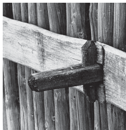
Durchsteckzapfen als Zapfenschloss, Rekonstruktion in Unteruhldingen am Bodensee
