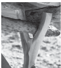
Die Gabel, in die der Firstbaum oder eine Pfette oder eingelegt wurde, gehört zu den frühesten Holzverbindungen.
