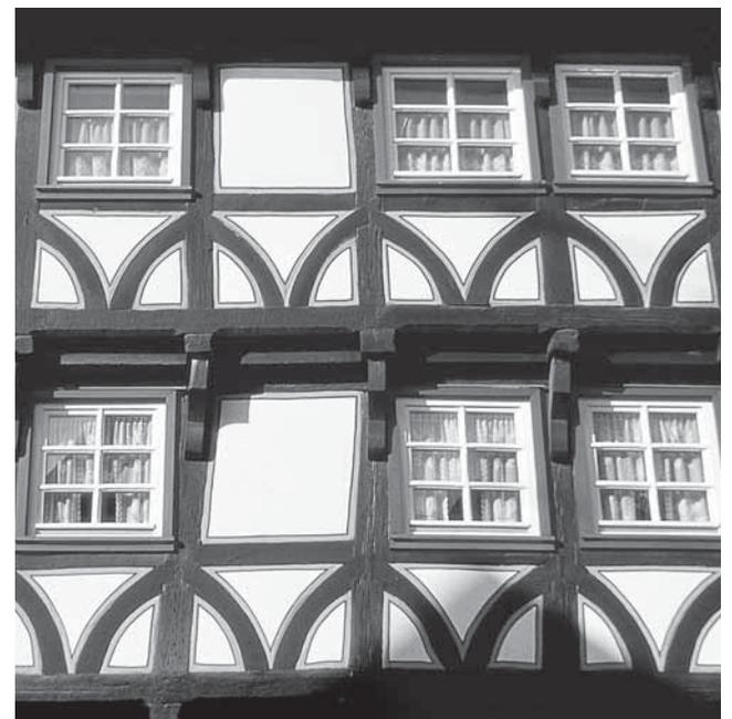
Typisches Merkmal end-mittelalterlicher Fachwerk-konstruktionen sind Einzelverstreben aller Ständer, Beispiel mit Radstreben in Alsfeld.
