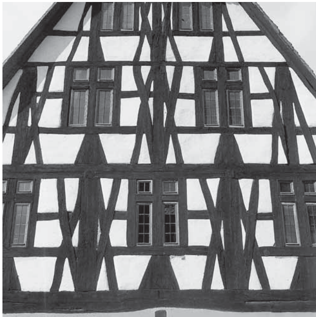
Übergangszeit: Ratshaus Michelstadt im Odenwald, 1484, verzimmert. Die Ständer sind nicht mehr einzeln verstrebt, sondern die Wände durch geschosshohe Verstrebrungen an den Bund- und Eckständern ausgesteift.
