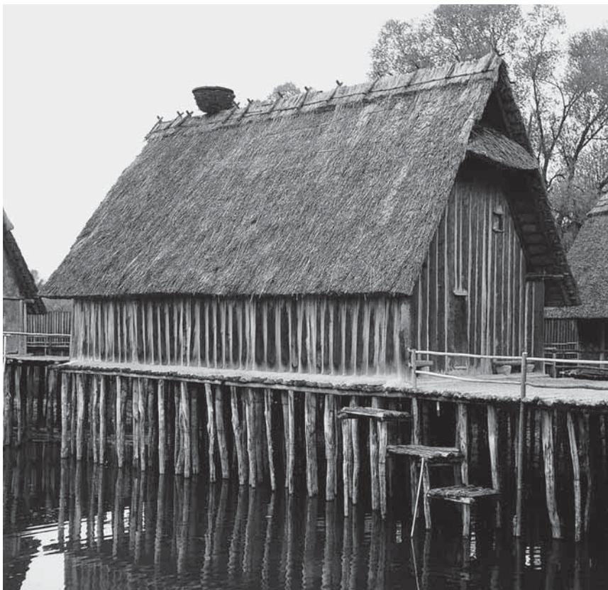
Rekonstruierter Stabbau auf einer Pfahlkonstruktion in Unteruhldingen
