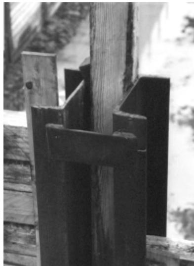
Bild 4.26 Bohlträger aus ][-Profilen
