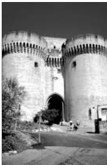
Die Zwillingstürme des Fort Saint-André
