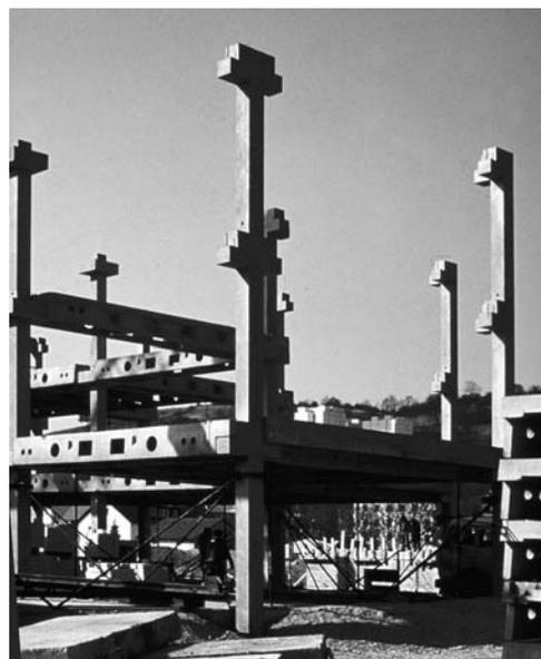
**36** Seitenansicht des oben gezeigten Tragwerks. Die Rippen der Deckenelemente sind zur Durchleitung von Installationen perforiert.
