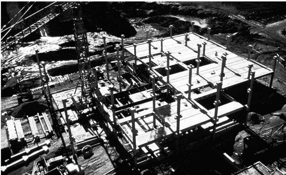
**35** Tragwerk eines Fertigteilbaus im Bauzustand: einachsige spannde vorgefertigte Deckenplatten auf Unterzügen, über drei Geschosse durchgehende Fertigteilstützen mit Konsolenauflegern.
