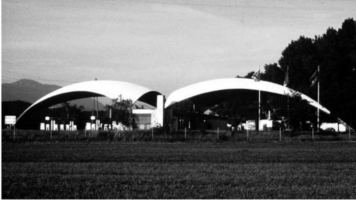
1 Druckbeanspruchtes Tragwerk.
