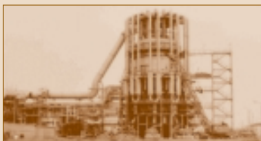
Alkanhefe-Bioreaktor (42 m hoch) in Schwedt zu DDR-Zeiten
