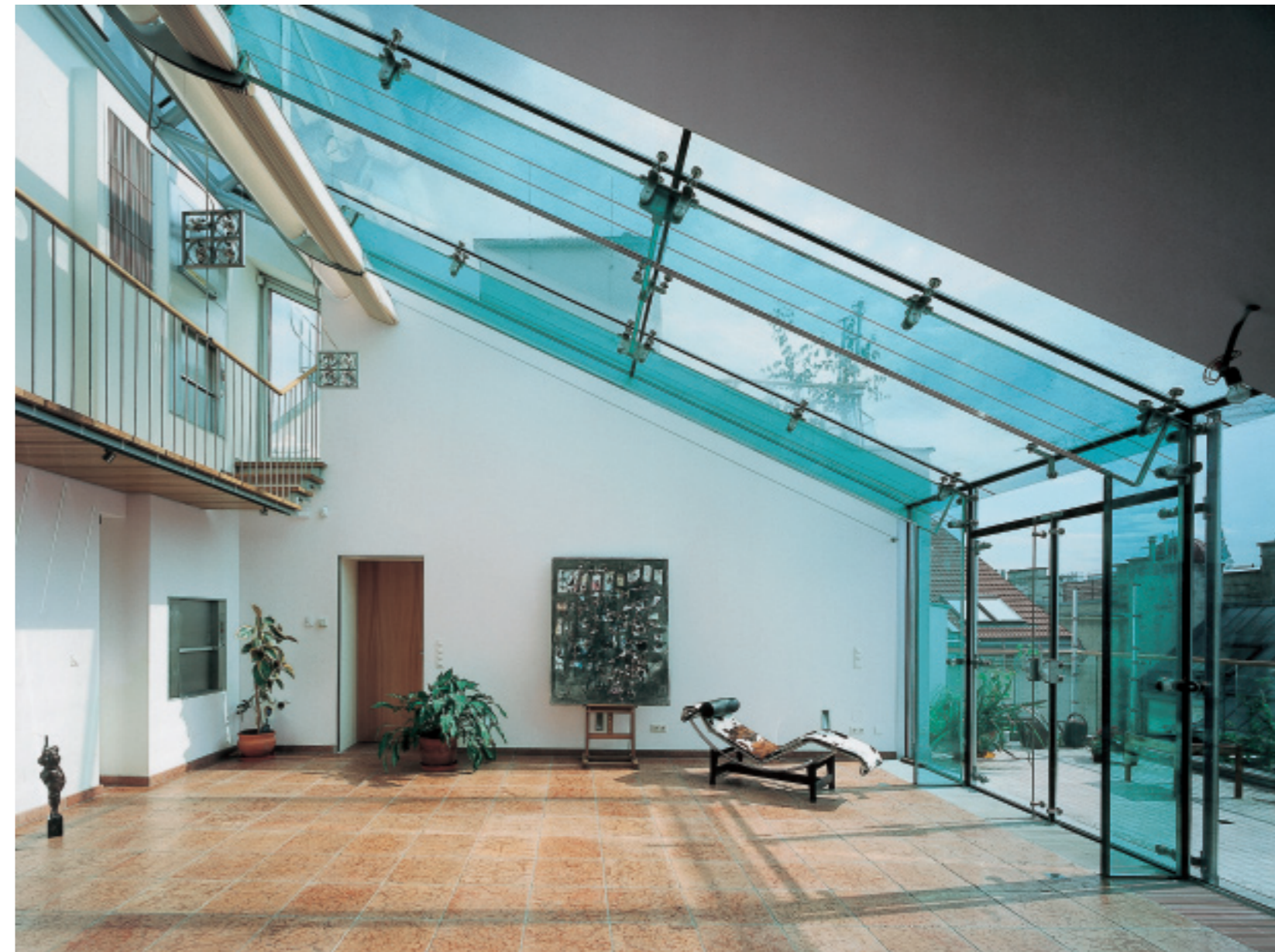
Das Atelier, Zentrum der Wohnung, wird von einer faszinierenden Nur-Glas-Konstruktion überdacht.
