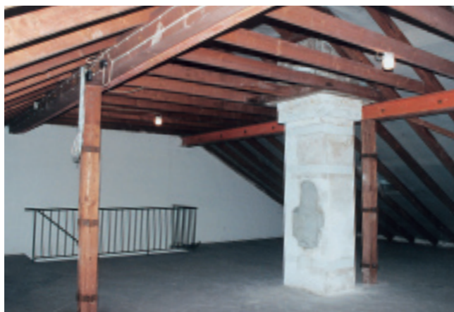
Der Zustand des Raumes vor seinem Ausbau.
