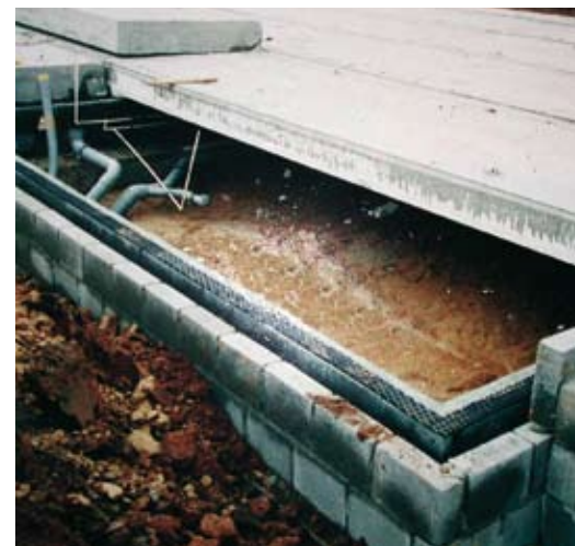
Die Decke über dem Kriechkeller wird aus vorgefertigten Elementen zusammengesetzt
