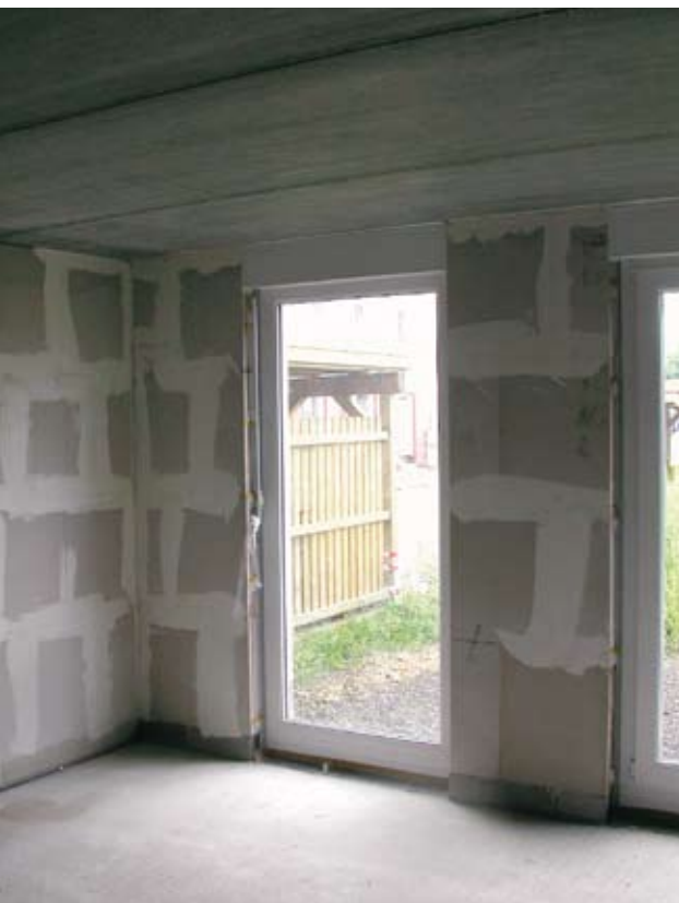
Innenseitig verspachteltes Außenmauerwerk aus großformatigen Planellementen
