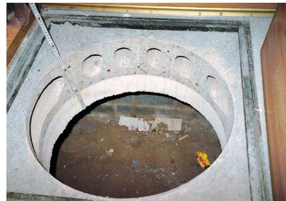
Zugang zum Kriechkeller über eine Bodenluke
