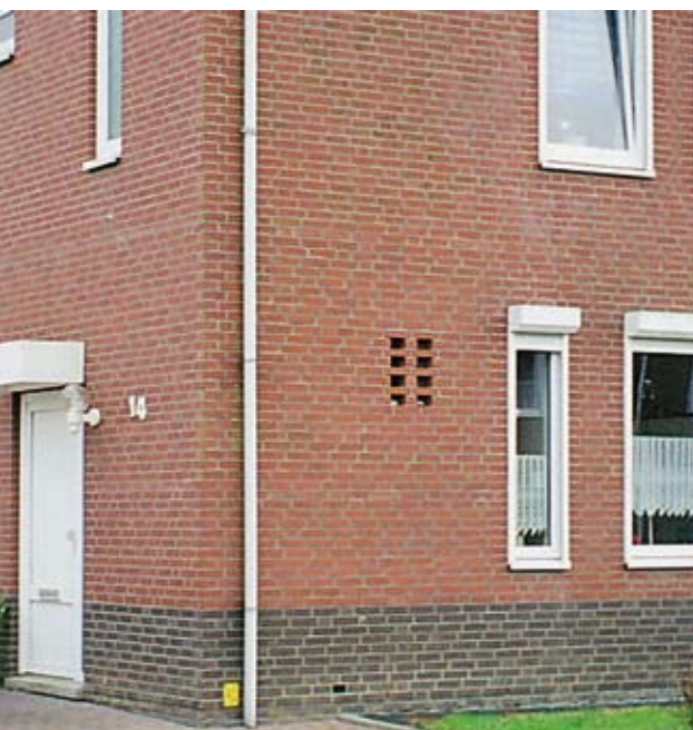
Unten: Verwendung frostbeständiger Klinker im Sockelbereich
