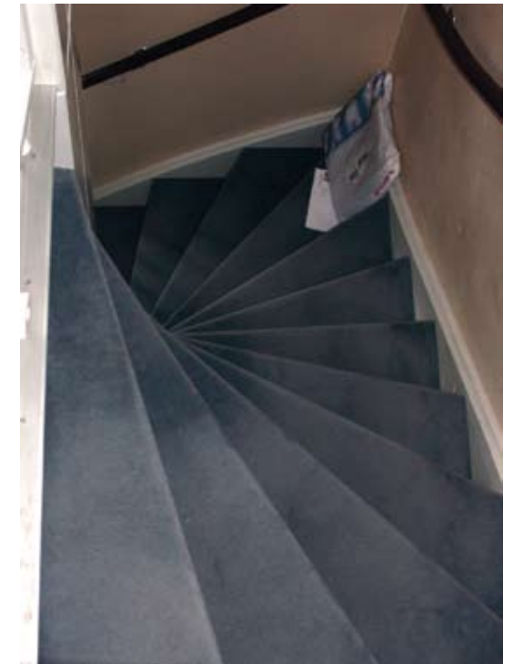
Niederländische Treppe mit extrem steilem Steigungsmaß
