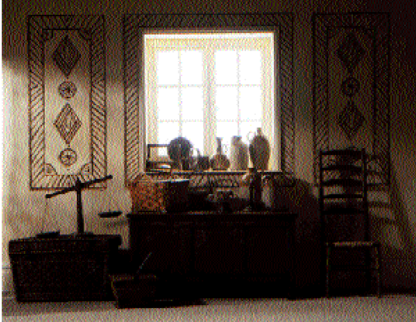
OBEN: In ländlichen Regionen Frankreichs ritzte man dekorative Muster direkt in den feuchten Verputz. Hier sind die Konturen des Musters auf der Wand mit verdünnter brauner Farbe nachgezogen.
