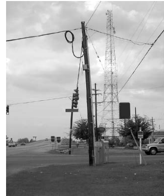
Die Langzeitwirkung der Kabellast verursacht eine Deformation des Mastes aufgrund von Kriechen.
