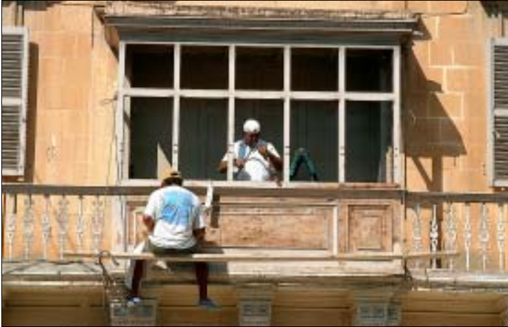
Erkerrenovierung in Victoria
