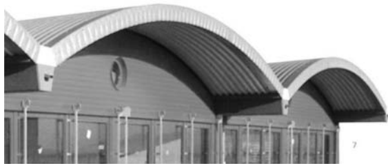
Bild 5-104 Zur Aufnahme der Regenrinne ausgebildete Traufriegel – a) Außenrinne, b) Kehlrinne
