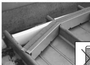
Einsetzen von Schließblech und Profillfüller
