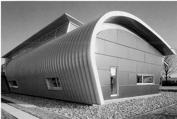
Bild 5-88 Deckung aus walzgerundeten Aluminium-Stehfalzprofilen
