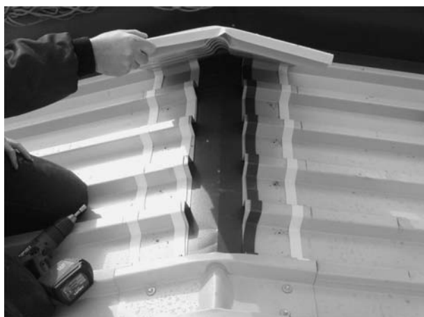
Bild 5-31 Firstabdeckung mit profilfolgender Kappe
