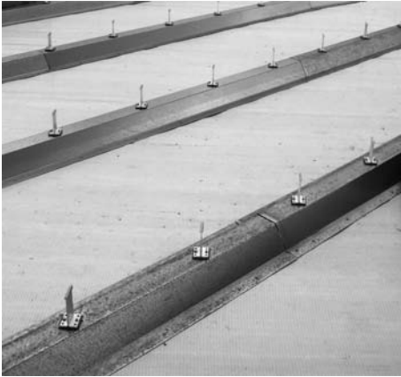
Bild 5-16 Diagonale Verlegung von Distanzprofilen auf der Dampfsperre einer tragenden Dachunterschale
