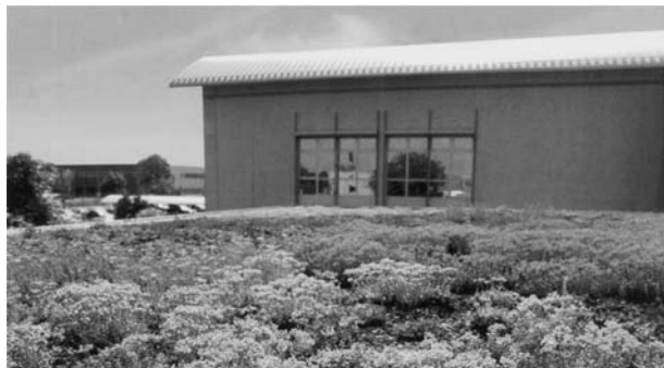
Bild 5-107 Dachbegrünung mit niedrig wachsenden Pflanzen
