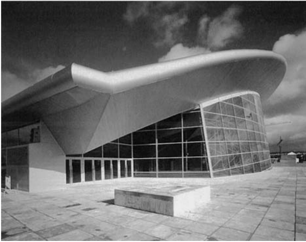
Bild 5-95 In unterschiedlicher Form walzgerundete Deckungen aus Aluminium-Stehfalzprofilen
