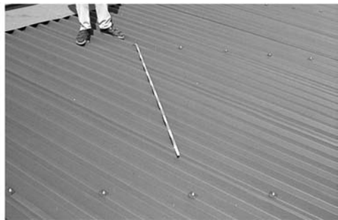
Bild 5-17 Schäden an der Dachoberschale nach diagonaler Verlegung von Distanzprofilen infolge übergroßer Abstände zwischen den Profilen
