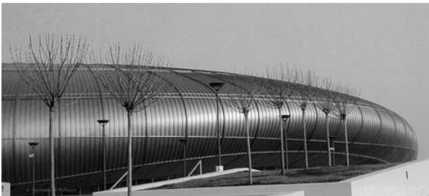
Bild 5-96 Deckung aus konisch verlaufenden walzgerundeten Aluminium-Stehfalzprofilen
