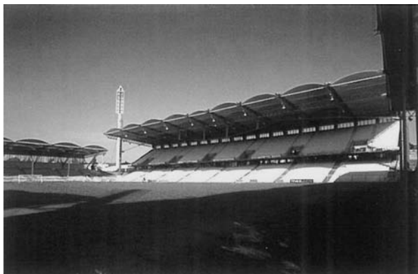
Bild 5-94 Frei tragende Trapezprofilbögen als Tribünenüberdachung
