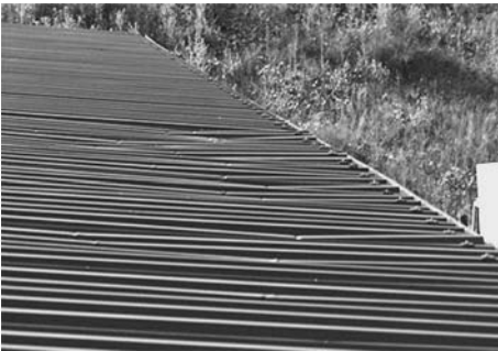
Bild 5-17 Schäden an der Dachoberschale nach diagonaler Verlegung von Distanzprofilen infolge übergroßer Abstände zwischen den Profilen
