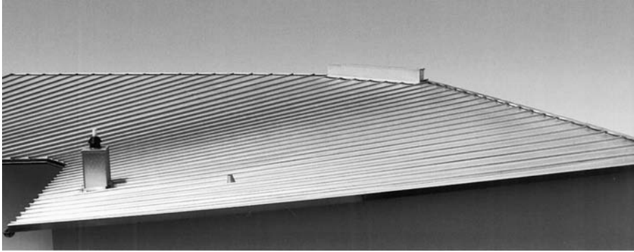
Bild 5-26 Dachdeckung mit Profiltafeln
