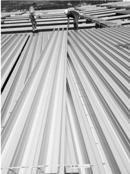
Bild 5-4 Verlegung von Stahltrapezprofilen als tragende Dachunterschale
