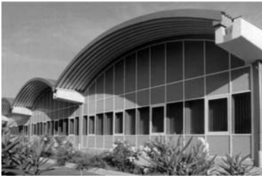
Bild 5-102 Traufriegel und Zugbandverbindung zur Aufnahme von Horizontallasten
