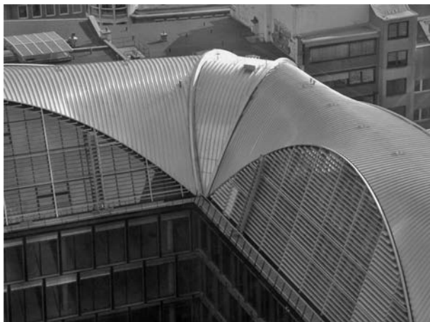
Bild 5-97 Mehrfach gekrümmter zweischaliger wärmedämmter Dachaufbau
