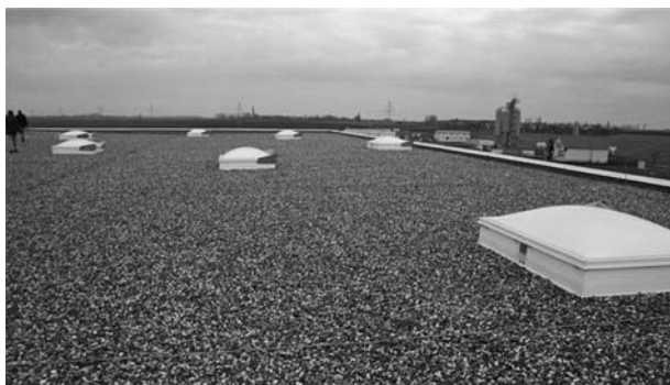
Bild 5-13 Bekiesung einer Dachoberfläche
