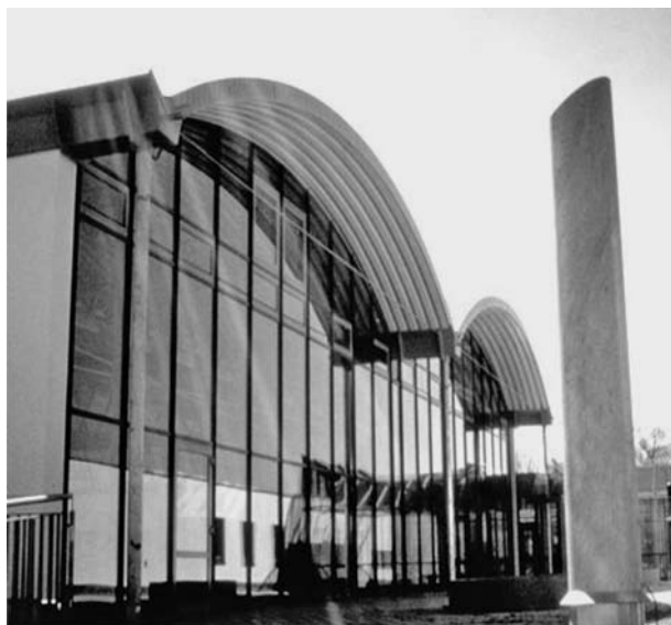
Bild 5-87 Frei tragendes zweischaliges Bogendach
