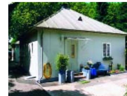
Oben: Dieses nach dem System Blecken erstellte Stahlblech-Haus in Essen befindet sich noch heute weitgehend im Originalzustand.
