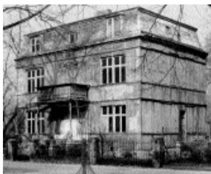
Oben und Mitte: Das 1883 von der MAN errichtete Stahlfachwerkhaus in Nürnberg. Nach Fertigstellung blieb die tragende Konstruktion außen sichtbar.
