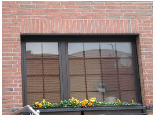
Bild 2.3.20 Grenadierschicht als Fenstersturz
